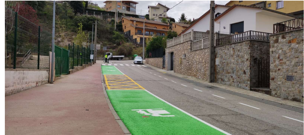
Exemple ampliació voreres escola Santa Eulàlia.
